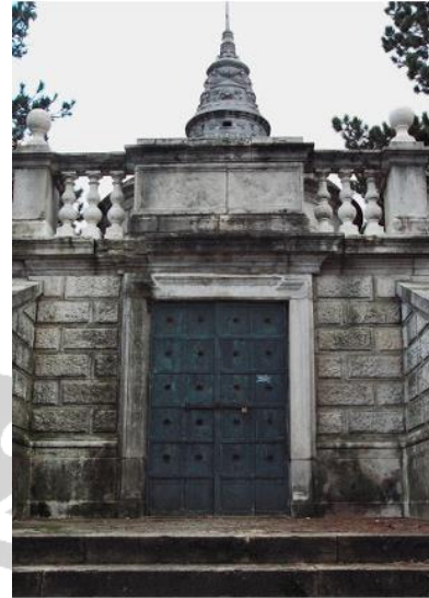
A kilátó hátoldala, még díszkút életében a kútkezelő bejárata volt
